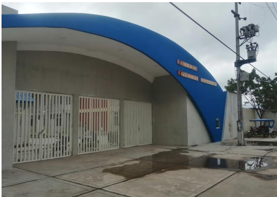
INGRESO PRINCIPAL – CERCO FACHADA
